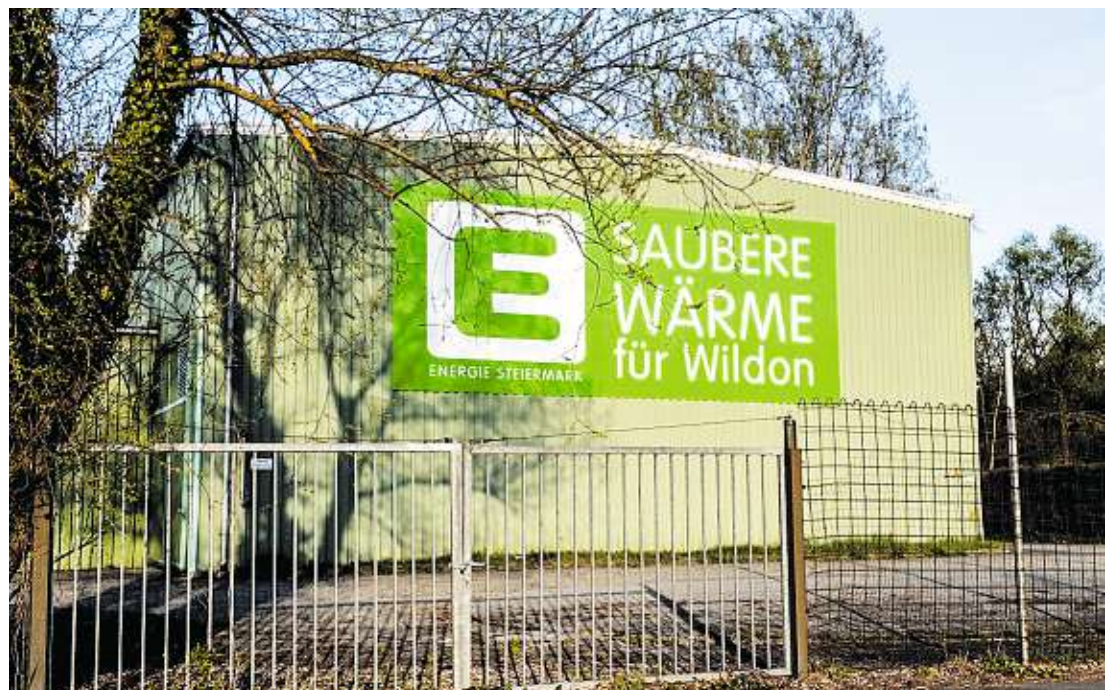
Das alte Biomasseheizwerk Wildon ist seit Kurzem wieder provisorisch in Betrieb
