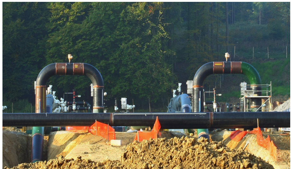
Baustelle Gasverdichterstation Weitendorf
