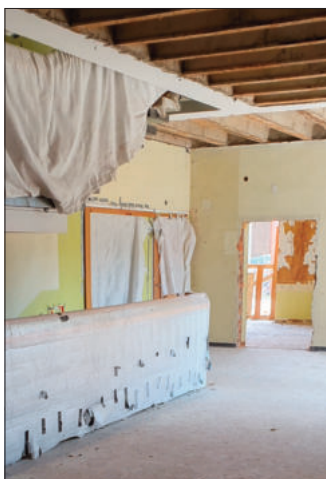
Alles wird nach neuen Standards saniert.
