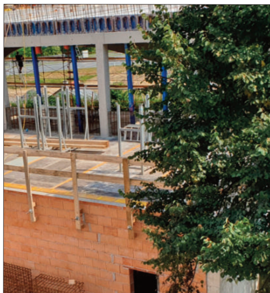
Auf einem Teil der Nebenräumlichkeiten entsteht der Freiluft-Pausenbereich.
