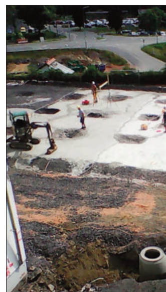
Der problematische Untergrund im gesamten Bereich, der durch den Bodenmechanik-Gutachter festgestellt wurde, machte das Verpressen von mehr als 150 Betonpfählen notwendig. Fotos: Josef Hirschmann
