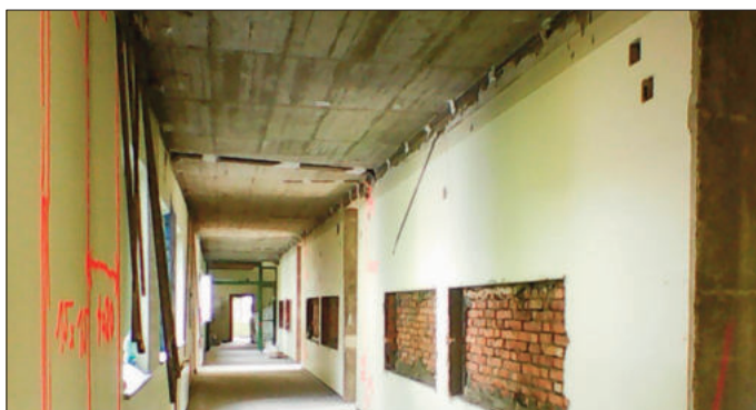
Wichtige Vorarbeiten wie die Entfernung aller Holzdecken haben unsere Gemeindearbeiter ausgeführt.
